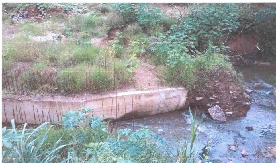
Foto 1 – 1º trecho das paredes da galeria para junção das ruas Padre Vicente Priant e dos Joãos de Barros antes da construção da galeria, abas e arruamento. Foto: Autor, Março de 2015.
